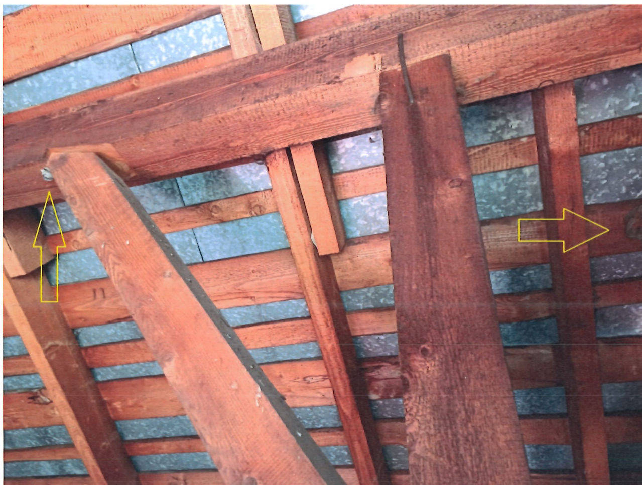
Pozostałości gniazd os w obrębie konstrukcji nośnej dachu.
